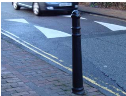
I I a. Simple cast iron bollard
